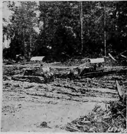
UNA MODERNA PISTA DE ATERRIZAJE — Aquí daba inicio la construcción del campo de aterrizaje, dos poderosos Caterpillar en su misión. Obsérvese el terreno: sólo lodo, pero ellos terminaron su trabajo y dejaron lista una moderna pista de aterrizaje para aviones pequeños y grandes.
